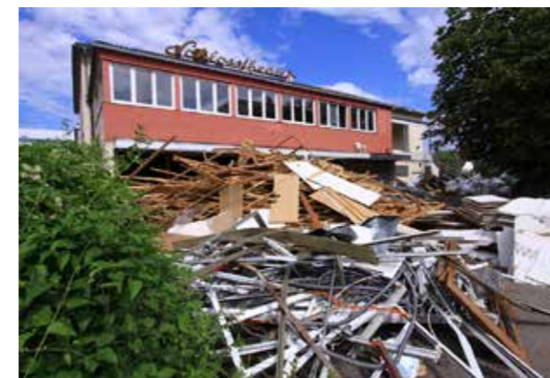
Das Schlosstheater wurde Mitte 2012 abgebrochen. Heute könnte so nicht mehr abgebrochen werden. Alle Materialien müssen sorgfältig getrennt werden.
