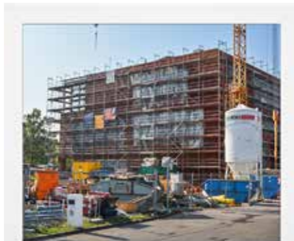
Rathaus im Bau
